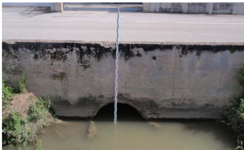
Foto 1: attraversamenti sottodimensionati
