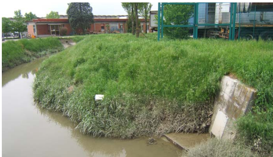
Foto 13: altre immissioni con quota di scorrimento di poco superiore al fondo del corpo ricettore.
