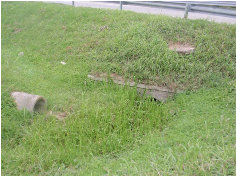
Foto 9: tubazione di attraversamento della SP con sbocco parzialmente ostruito
