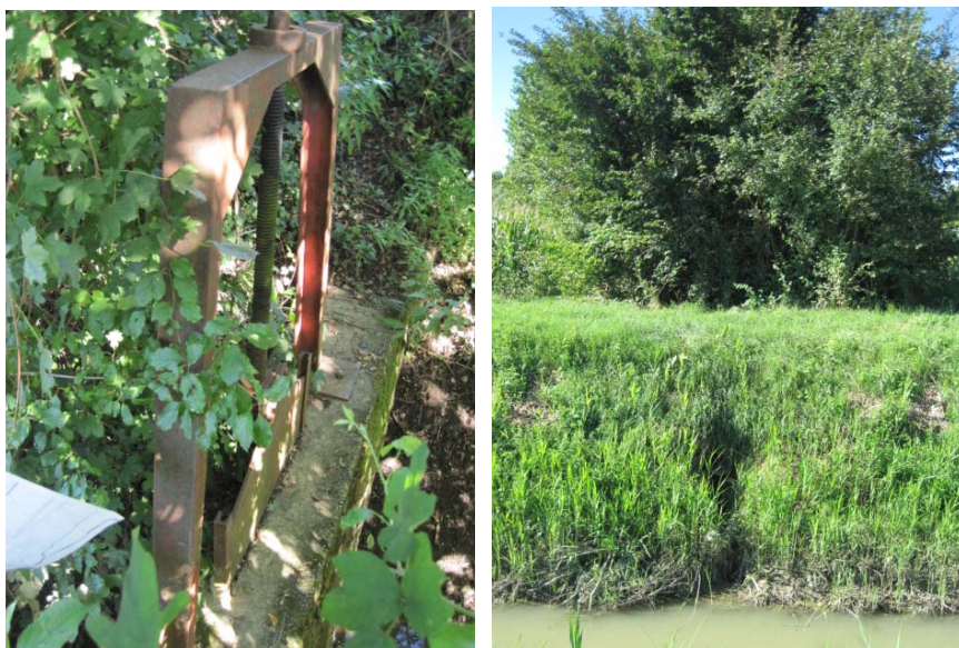
Foto 16: paratoia sul fosso di guardia della ferrovia ed immissioni in Pionca nella zona arginata, senza porte a vento
