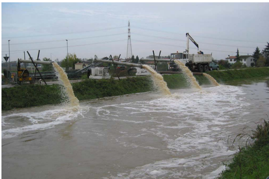
Foto 2: solamente con la installazione di pompe di emergenza con sollevamento delle portate nel Taglio di Mirano si possono, a volte, evitare tracimazioni arginali.
