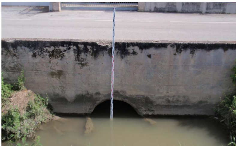
Foto 15: attraversamenti sottodimensionati
