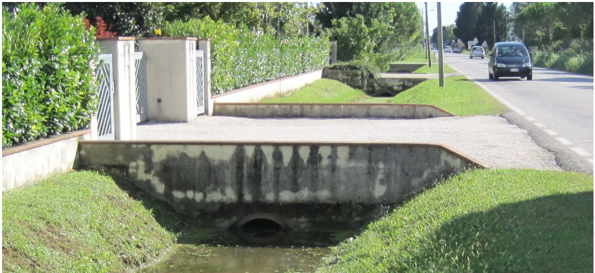
Foto 14: presenza di numerosi tombinamenti parzialmente ostruiti sui capofossi principali
