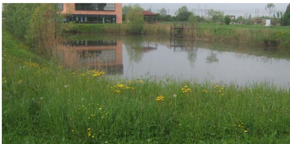
Foto 11: unico esempio di invaso per la compensazione delle portate nell'area industriale di Pianiga
